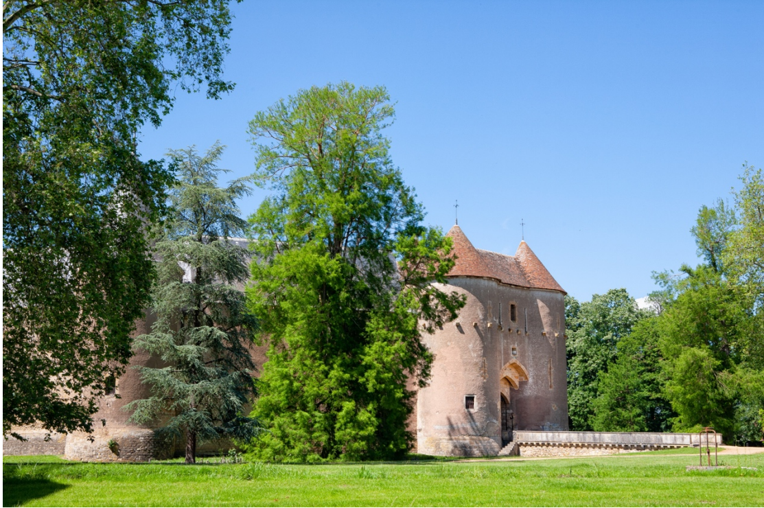
Une vue imprenable sur l'entrée du monument, son corps de garde et son pont dormant.
